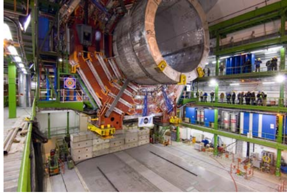
fig.5.: descente d'une des 9 tranches de CMS dans la caverne de l'expérience, située 100 m sous terre.
